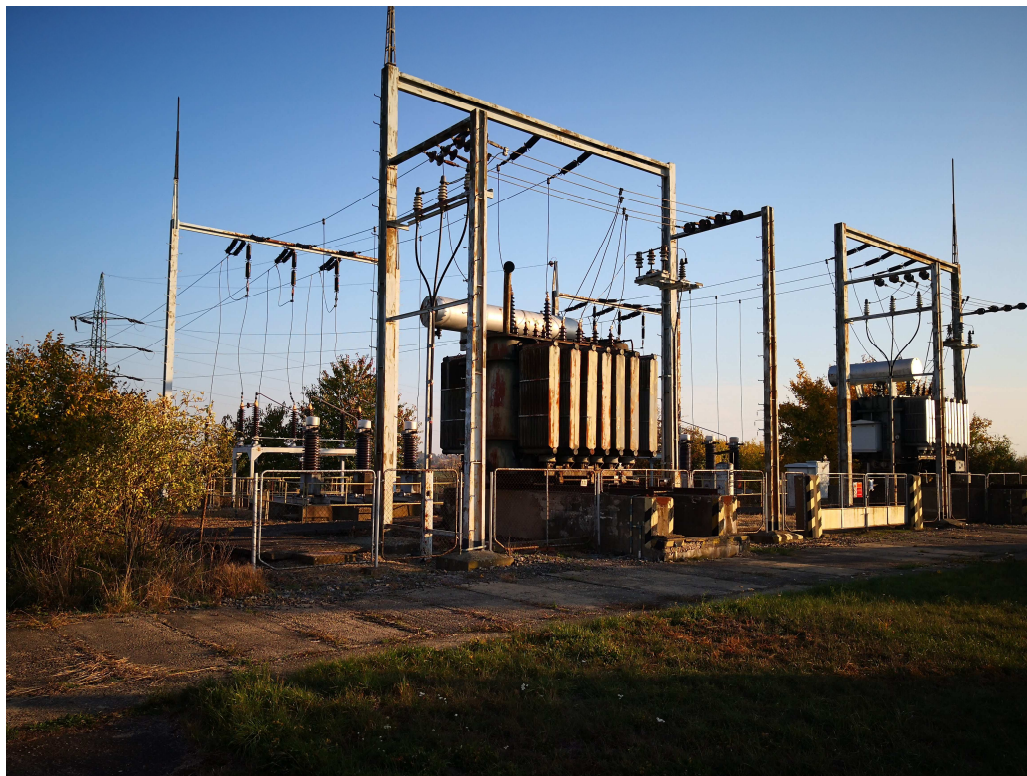
Obr. 1 – Celkový pohled ze západní strany na obě stanoviště transformátorů TNS Rostoklaty. Vlevo je transformátor 100/23 kV ozn. T102, vpravo je transformátor 110/23 kV ozn. T101
