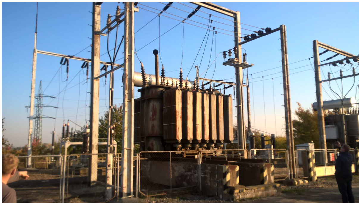
Obr. 5 – Pohled na transformátor 100/23 kV ozn. T102, typu 1 ER 27 M výrobce ZVIL Plzeň (r.v. 1955). Nad transformátorem je ukotvení lanových převěsů a klasičky 110 kV připojené na primární průchodky a 4 lanové přípojnice 22 kV včetně vyvedení uzlu sekundárního vinutí. Vpravo je vyvedení uzlu vinutí 110 kV a kabelovým svodem je připojeno do zemnicí jámky na uzemnění.
