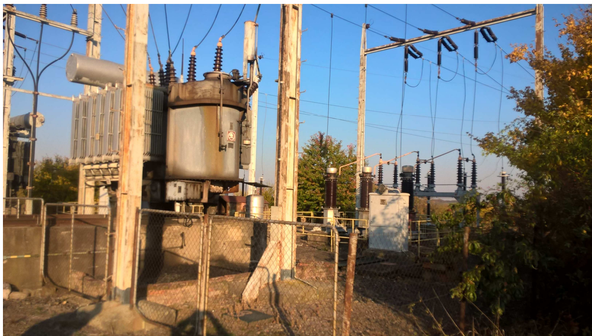
Obr. 8 – Pohled na regulaci odboček pod zatížením transformátoru T101.
