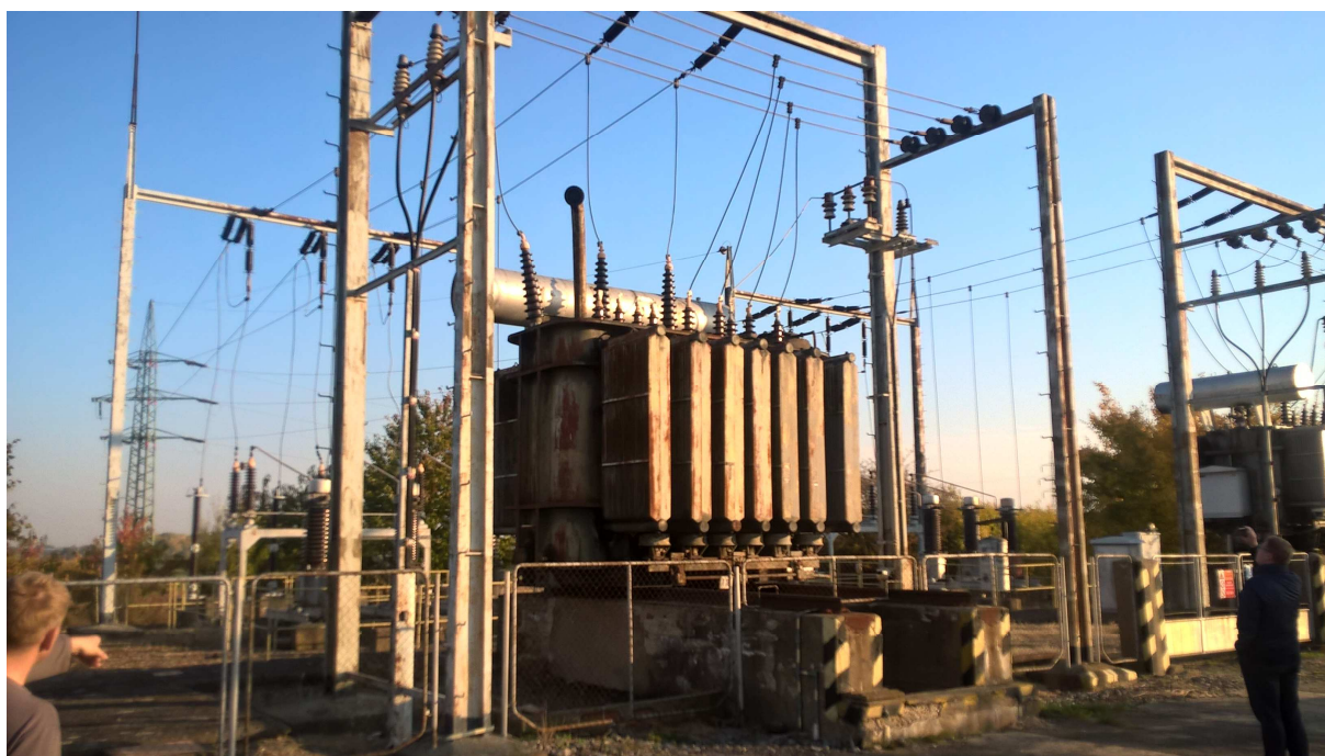
Obr. 9 – Celkový pohled na transformátor T102 umístěného na základu s kolejnicemi s rozchodem 1900 mm.
