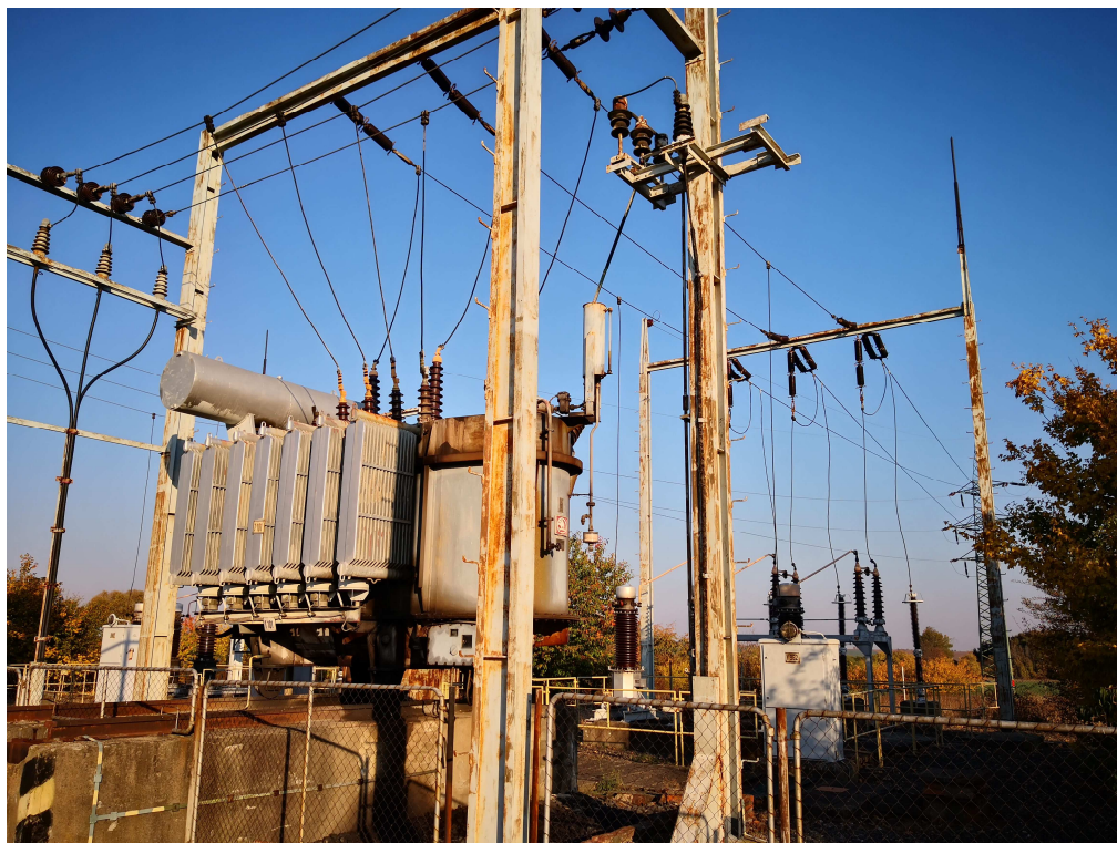
Obr. 3 – Pohled na transformátor 110/23 kV ozn. T101, typu 6 ERH 27M-0 výrobce Škoda k.p. Plzeň (r.v. 1987). Vpravo jsou napájecí převěsy s klasačkami 110 kV na průchodky transformátoru 110 kV, vlevo jsou lanové přípojnice 22 kV připojené klasačkami ze sekundárních průchodek transformátoru.
