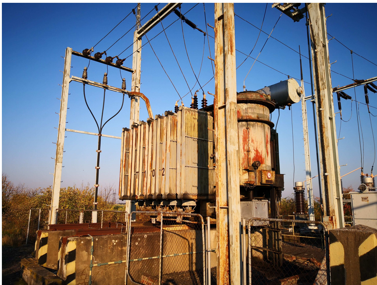
Obr. 10 – Pohled na přepínač regulace napětí pod zatížením transformátoru T102 umístěného na základu s kolejnicemi s rozchodem 1900 mm.
