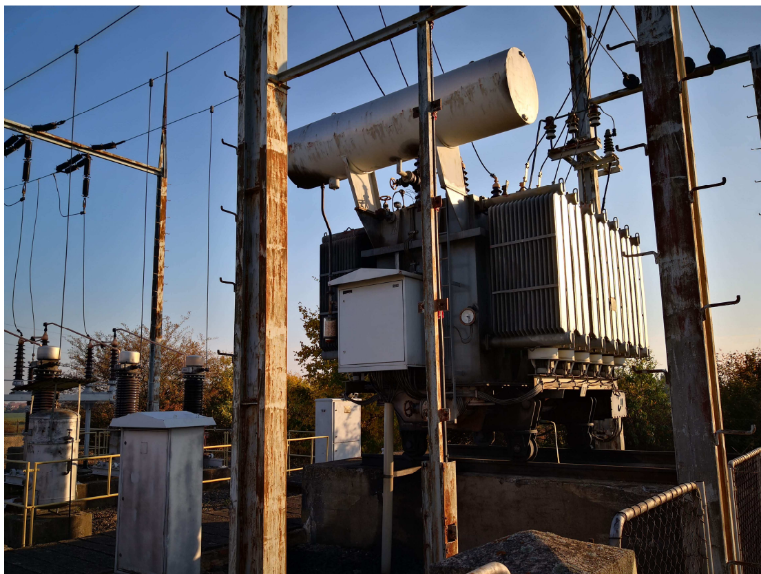
Obr. 7 – Pohled na svorkovnicovou skříň transformátoru T101. Vlevo je ovládací skříň transformátoru
