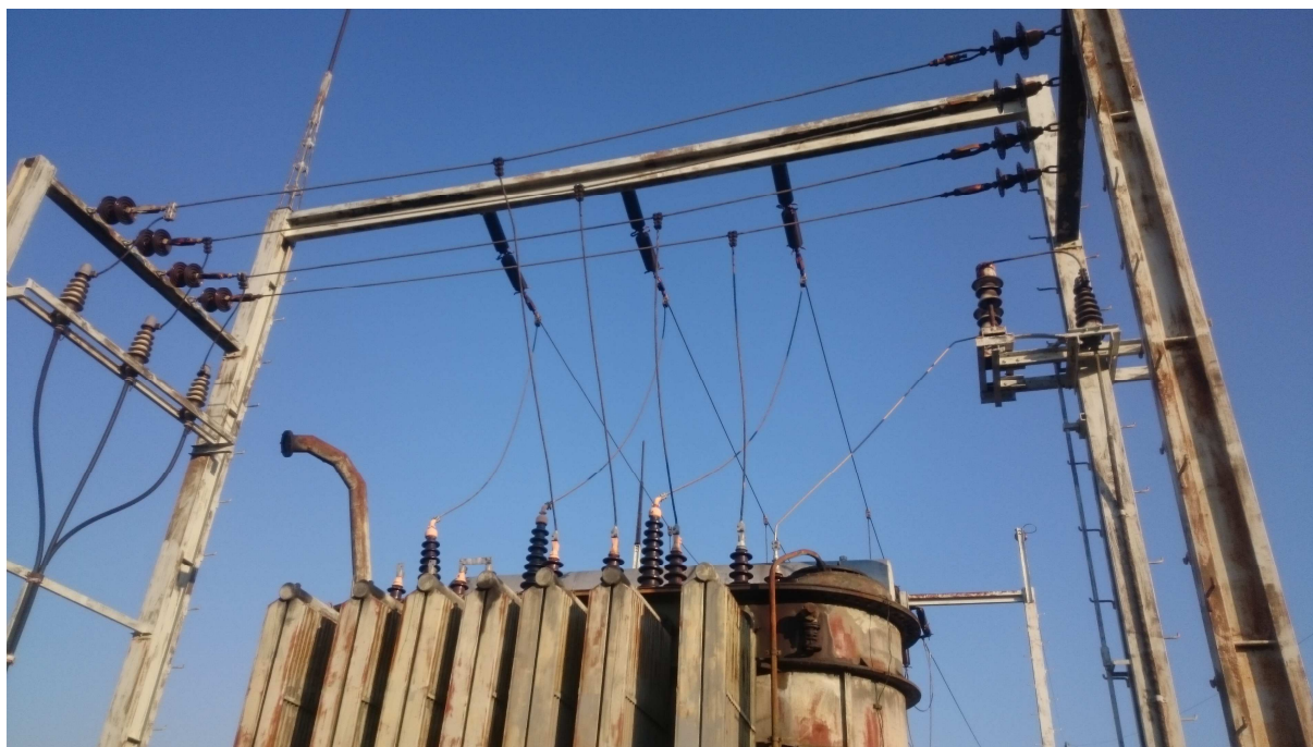
Obr. 4 – Lanové převěsy nad transformátorem T101. Z převěsů 22 kV je proveden kabelový svod (na obr. vlevo) jednožilovými kabely ukončenými v kobce přívodu 22 kV v budově měnirny. Vyvedený střed sekundárního vinutí není nikam připojen. Střed primárního vinutí je vyveden (na obr. vpravo) a je kabelovým vedením připojen na uzemnění
