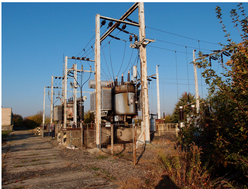
Obr. 2 – Celkový pohled z východní strany na obě stanoviště transformátorů TNS Rostoklaty. Vlevo je transformátor 100/23 kV ozn. T102, vpravo je transformátor 110/23 kV ozn T101.
